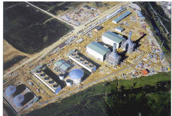
Fig. 2. Central de ciclo combinado de San Roque (Cádiz)
